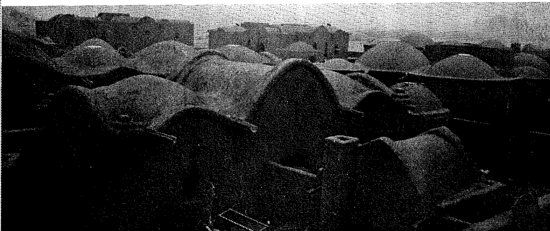
Infrastructure du PCGRNAT: bureau, logements, magasin, garage ... (Iférouane)
