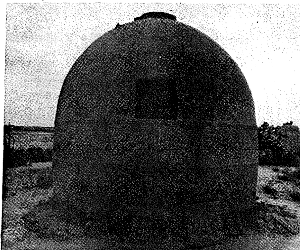
Grenier typique de beaucoup de régions du Sahel avec parois très minces en terre crue non-stabilisée. Le savoir-faire local existe pour qu'il résiste au climat...
