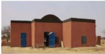
Logement d'enseignement à Goren Goren, Togo - ouest.
