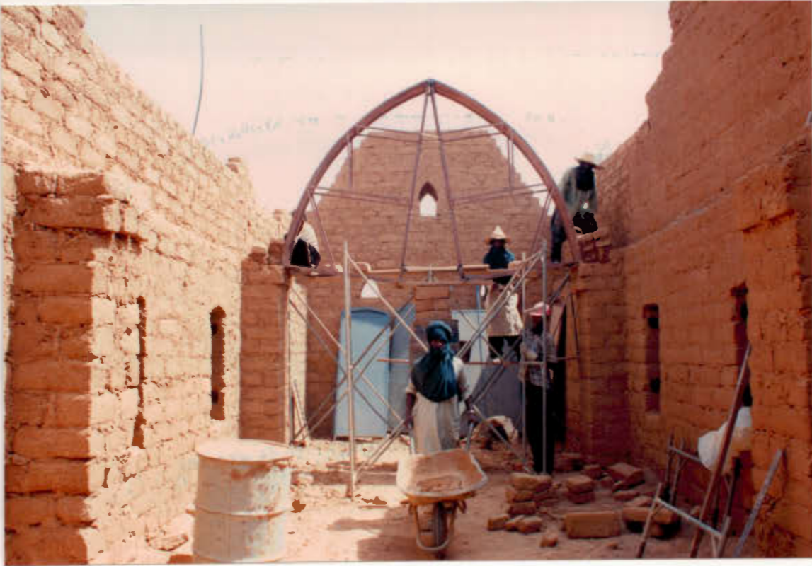
Ci-dessus: Bureau - salle de réunion en cours de construction.
