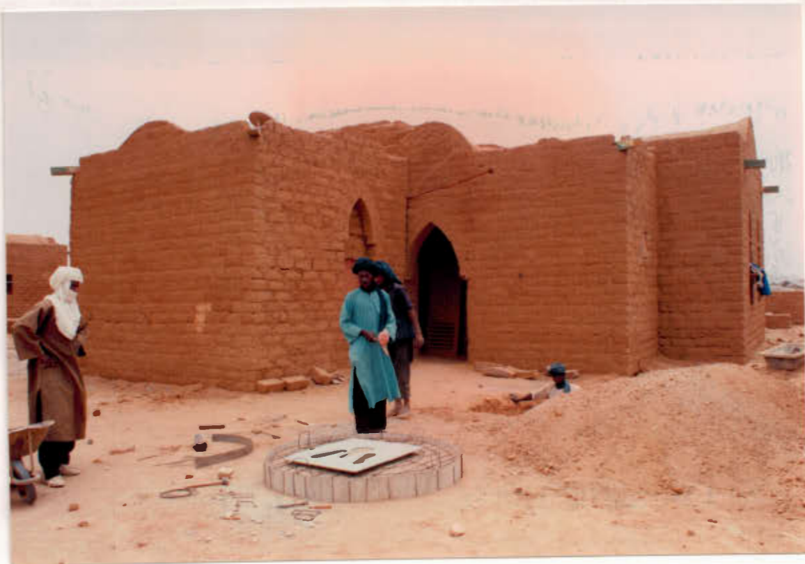
Ci-dessus: Villa V en cours de construction.
