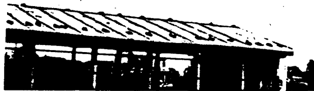
Hình 82: Gia cố toàn mái tôn
